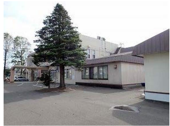
【北西側から見た現庁舎】
